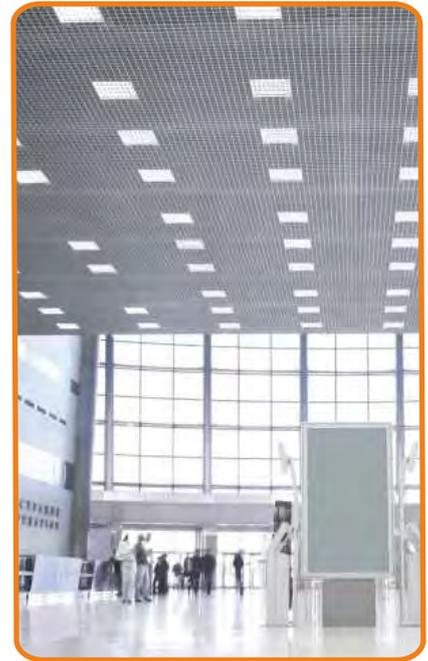
**Рассеиватель «призма»** (прозрачный пластик с мелким выпуклым геометрическим рисунком) обеспечивает равномерное распределение света, практически не снижая световой поток. LED лента расположена четырьмя рядами.
